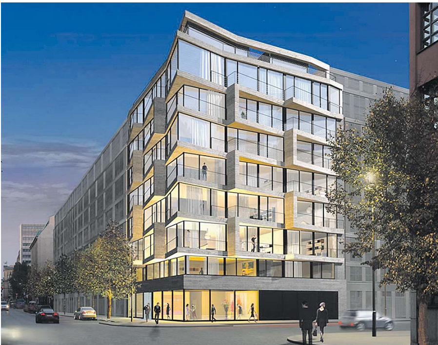
Eine schicke Eck-Bebauung soll bis Ende 2013 an der Charlottenstraße/Zimmerstraße wachsen. Sämtliche Einheiten waren schon vor dem Baubeginn im Mai vergeben. Bild: Zabel
